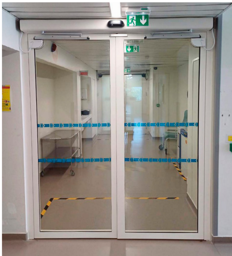
© Maf Atlantique - Porte Cardéa- Hôpital Ambroise Paré
